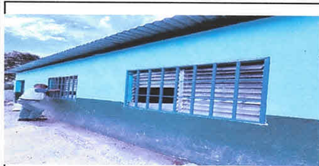
Foto 3: Sustitucion de balcones de metal
