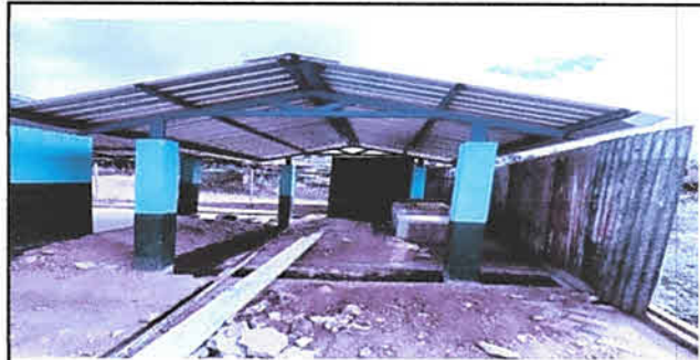
foto 8 reparación de cocina
