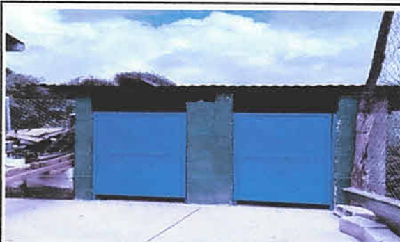
Foto 1: Sustitucion de puertas
