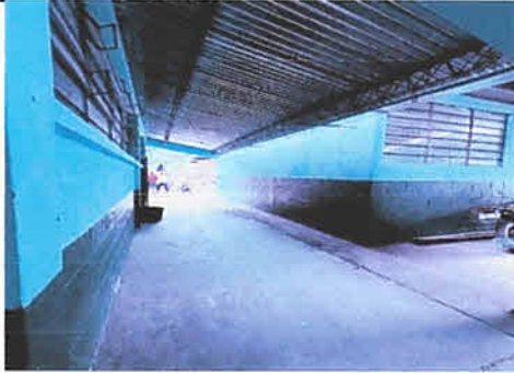
Foto 7; sustitución de canal de metal y reparación de bajada de agua puvrial
