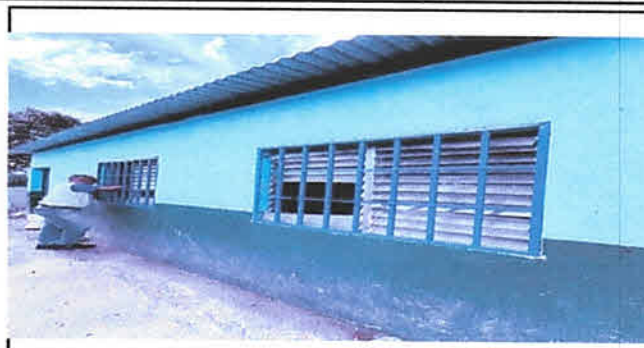
Foto 2: Sustitucion de vidrios de ventana s
