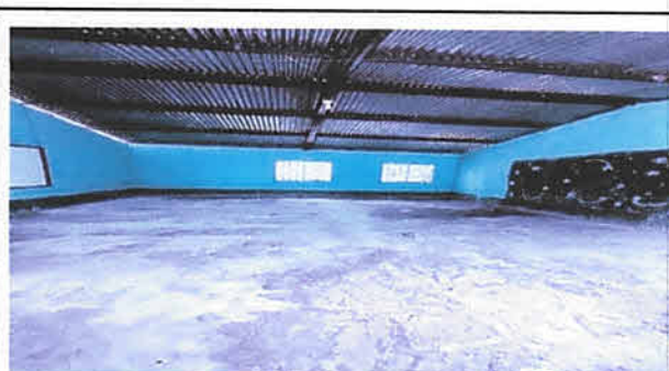
foto 4 sustitucion de torta de cemento
